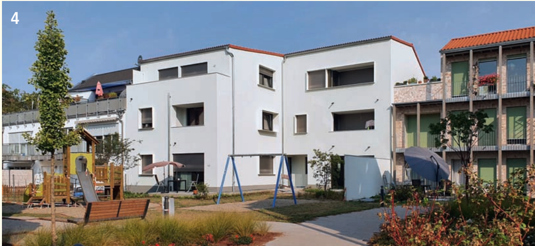
Bild 4 Fertiggerstellter Neubaukomplex Wohnen am Verna-Park in der Frankfurter Str. 39b
