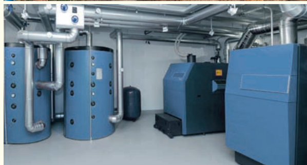
Das Nahwärmenetz wird von einer 380 Kwh Doppelkesselanlage in Gasbrennwerttechnik betrieben
