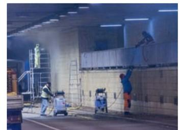
Bevor die Mitarbeiter der Straßenreinigung zu ihren Werkzeugen greifen können, muss erst einmal das große mobile Gerüst montiert werden. Es ist notwendig, damit das in Spritzschutzkleidung gehüllte Team die Wandfliesen im Bereich der Fahrbahn mit der Schaumkanone und dem Wasser-Hochdruckreiniger bearbeiten kann.
