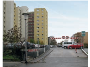
Das Parkdeck 4 in der Robert-Bunsen-Str. 29-31 wird noch in diesem Jahr durch eine moderne Holz-Stahl-Konstruktion ersetzt
