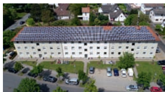
Photovoltaikmodule am neu gestalteten Wohngebäude Wilhelm-Sturmfels-Str. 37-41
