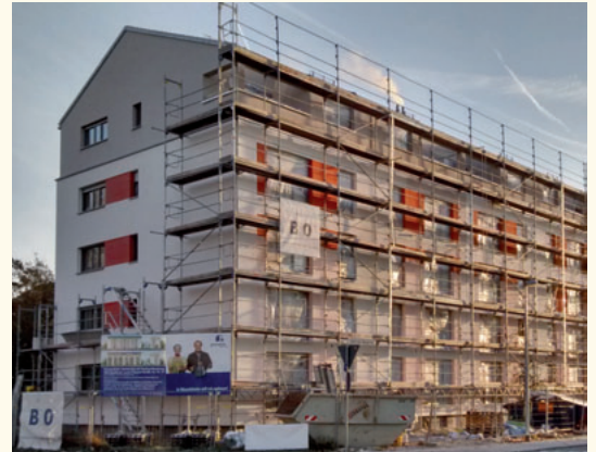
Aufstockung und Sanierung Lucas-Cranach-Str. 43-47
