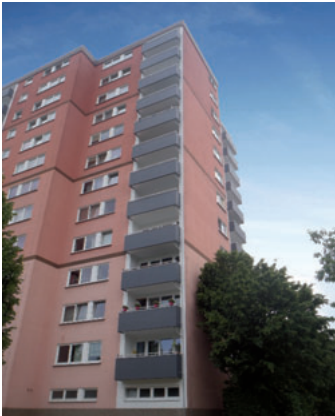
Balkonsanierung am Hochhaus in der Liebigstr. 20
