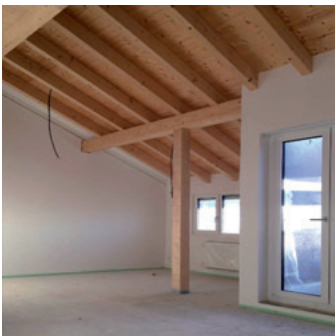
Dachgeschosswohnung im Wohngebäude Lucas-Cranach-Str. 43-47. Hier entstehen 6 neue Drei-Zimmer-Wohnungen
