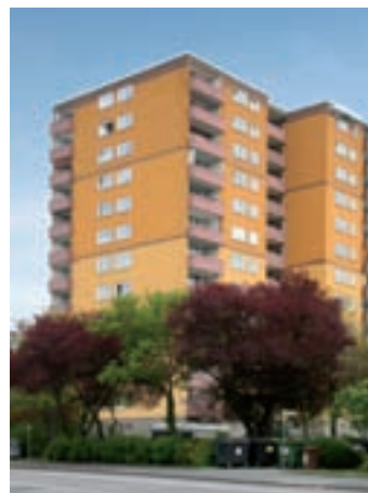
Am Borngraben 40, Rüsselsheim am Main: In diesem 12-stöckigen Haus wurden Bäder, Stränge und Anschlüsse saniert.
