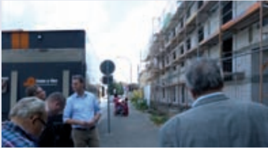
Oberbürgermeister Patrick Burghardt und Geschäftsführer Torsten Regenstein am Rohbau der Wohnanlage Böllenseeplatz 5-6
