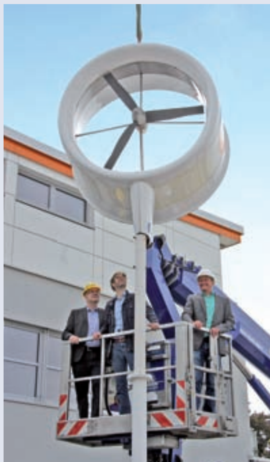
Hoch geht's: Matthias Schweitzer, Nils Kraft und Sven Halling (von links) verfolgen die Rückbringung des Windrads auf das Dach des Stadtwerkegebäudes.
