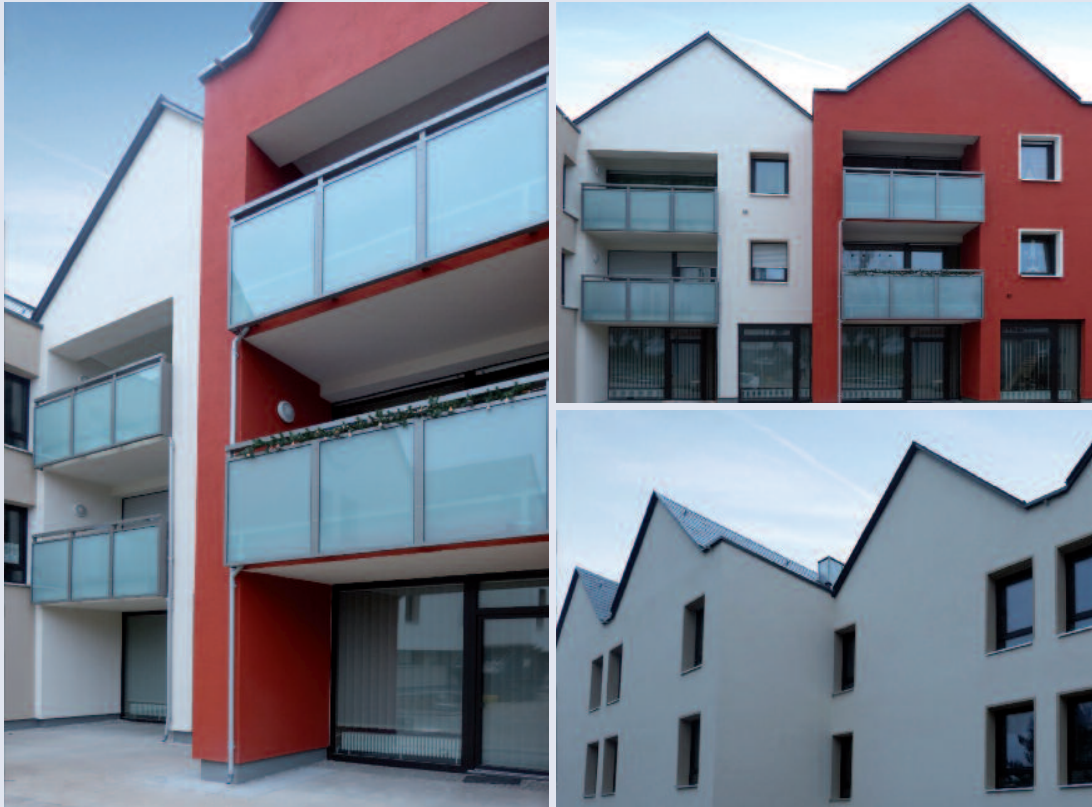
Die Seniorenwohnanlage in der Faulbruchstraße wurde von Grund auf modernisiert
