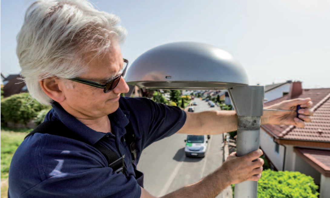
Herr der Leuchten: Michael Müller montierte in der Straße „Im Dorfband“ in Bauschheim die erste LED-Leuchte.
