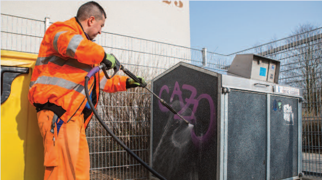
Farid El-Hasnoui bei der Graffiti-Entfernung an der gewobau Müllschleuse Paul-Ehrlich-Straße
