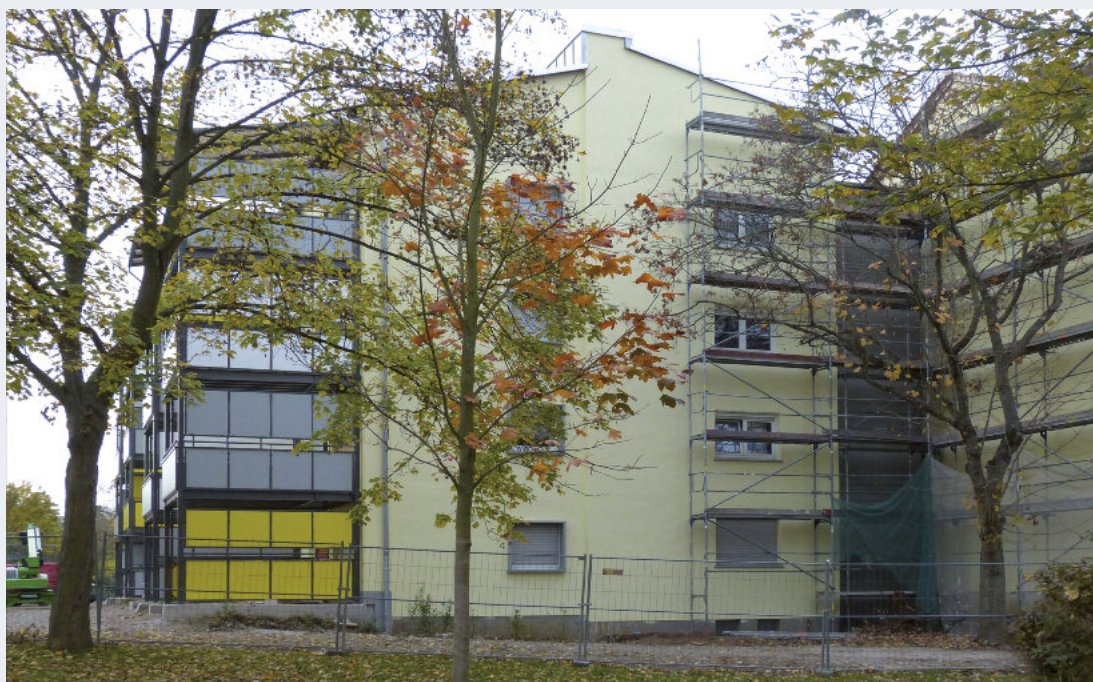
Sieht aus wie neu: Das im September 2013 aufwändig modernisierte Wohnhaus in der Käthe-Kollwitz Str. 32-40
