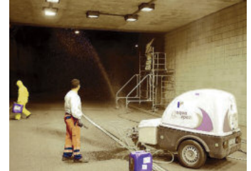
Intensivbehandlung: Mit Hochdruckdampfstrahlern und einer Spezialflüssigkeit rücken die Männer der Städtischen Betriebshöfe den verschmutzten Wänden zu Leibe.
