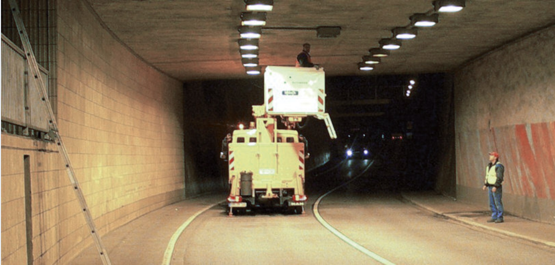
Eine von vielen Wartungsarbeiten in der Stadtunterführung: Der Austausch defekter Lampen
