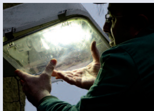
Moderne LED-Leuchten kommen auch im Aussenbereich der Wohnhäuser im Zuge einer Testphase zum Einsatz
